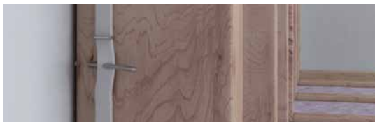
Les clous plantés dans le mur peuvent endommager les conducteurs dissimulés
